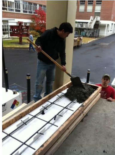
d: Concrete Pouring
